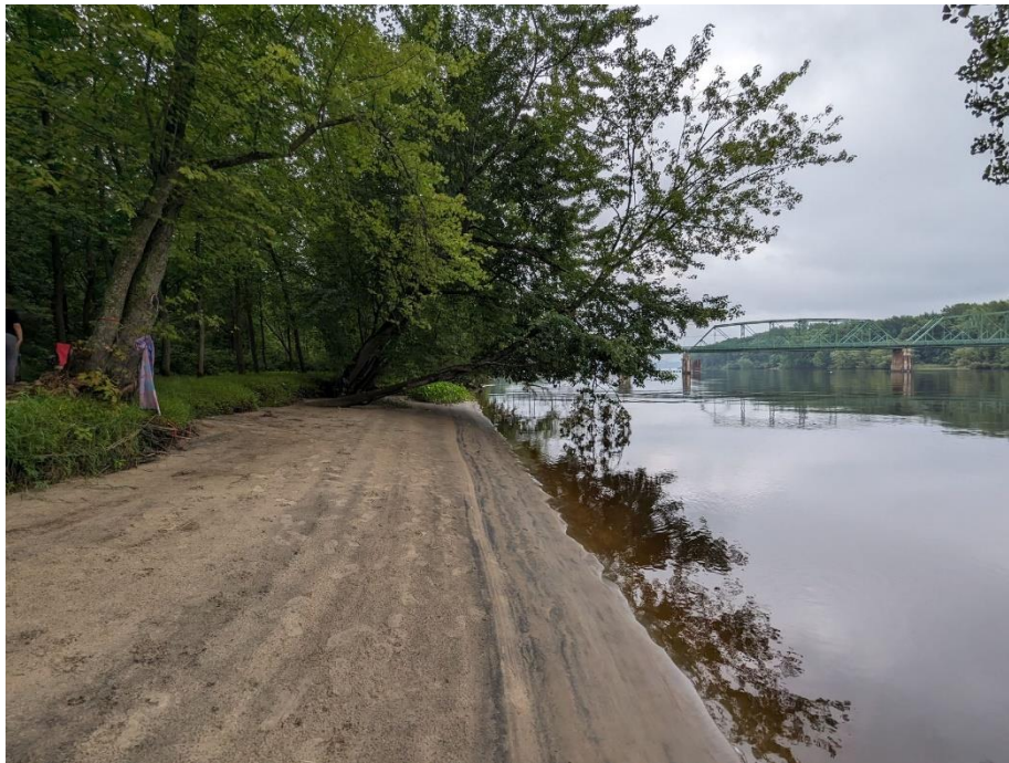
Photographie 8 : Accumulation de sédiments en rive, au pied de la microfalaise d'érosion, immédiatement en amont du pont de Batiscan. À noter, la chute progressive des arbres présents.
