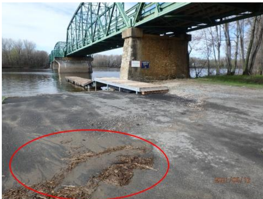
Figure 2.2 Laisses de crue au sol aval gauche
