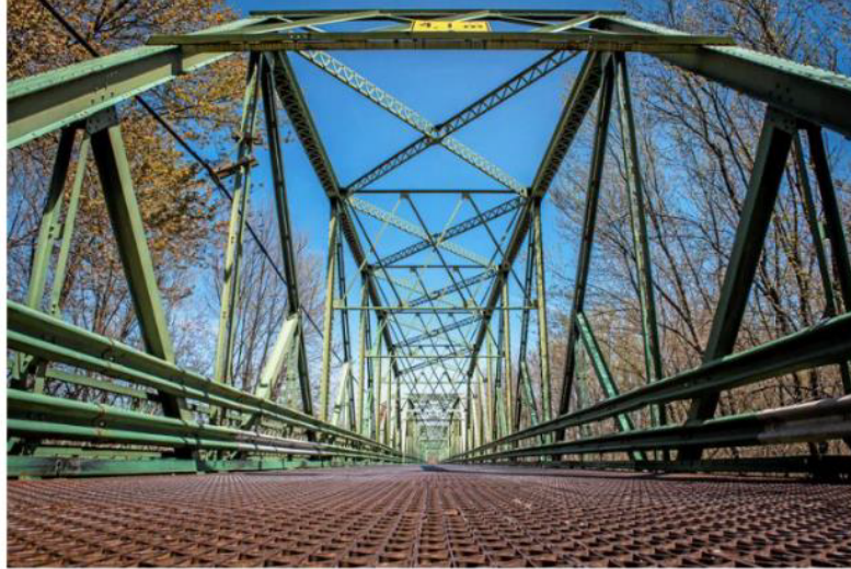
Des travaux sur le pont de la route 138 à Batiscan débutent ce lundi. (FRANCOIS GERVAIS/FRANCOIS GERVAIS)
