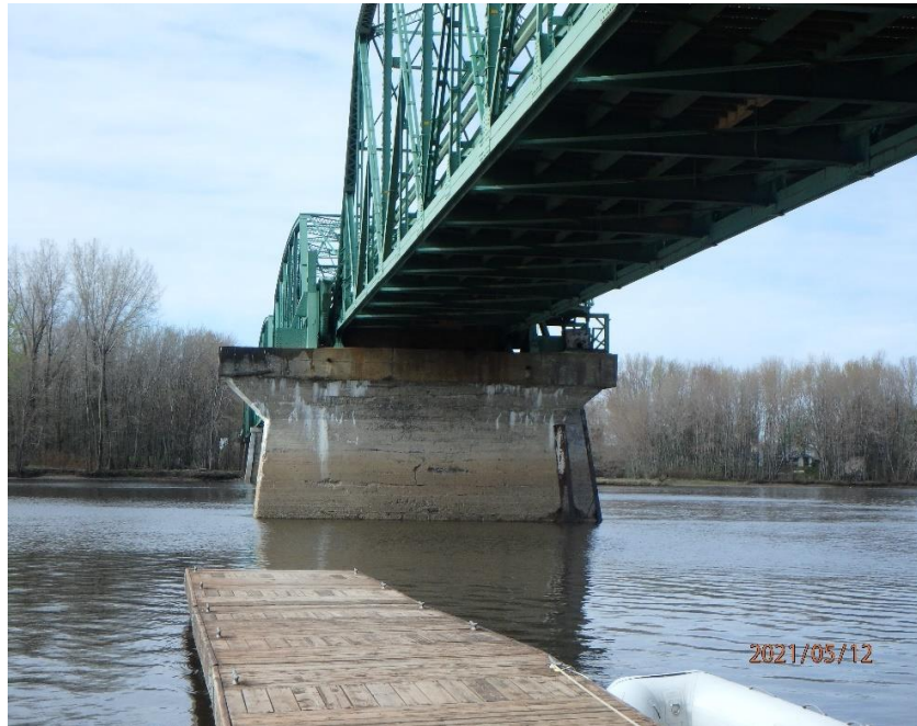
Figure 2.5 Marques sur une des piles du pont P-01559
