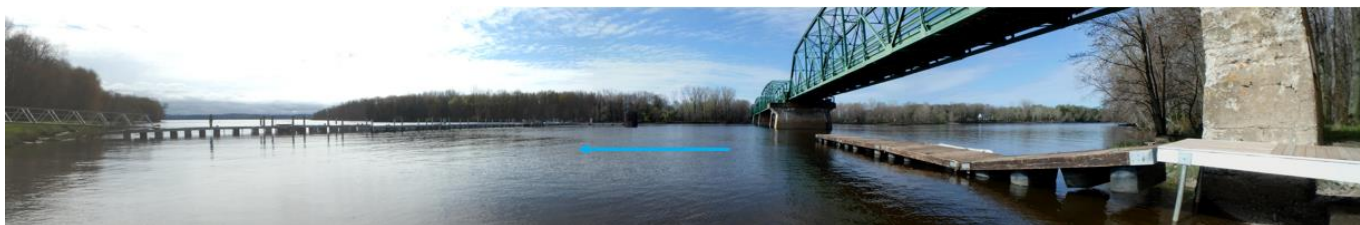
Figure 2.1 Vue panoramique de la structure P-01559 et du cours d'eau
