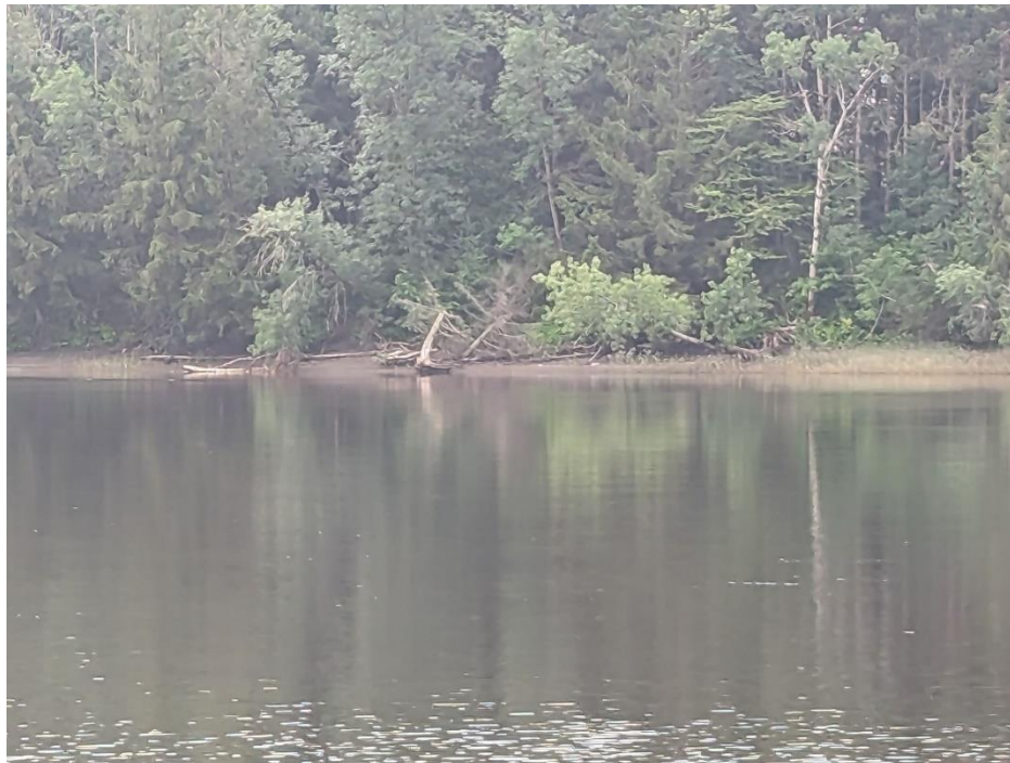
Photographie 2 : Érosion de la rive droite, secteur du pont de Batiscan.
