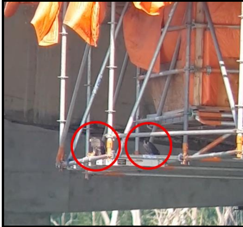
Figure 10. Faucon pèlerin adulte (à gauche) en alimentation et juvénile (à droite) sur un échafaudage au PIAT en 2023
