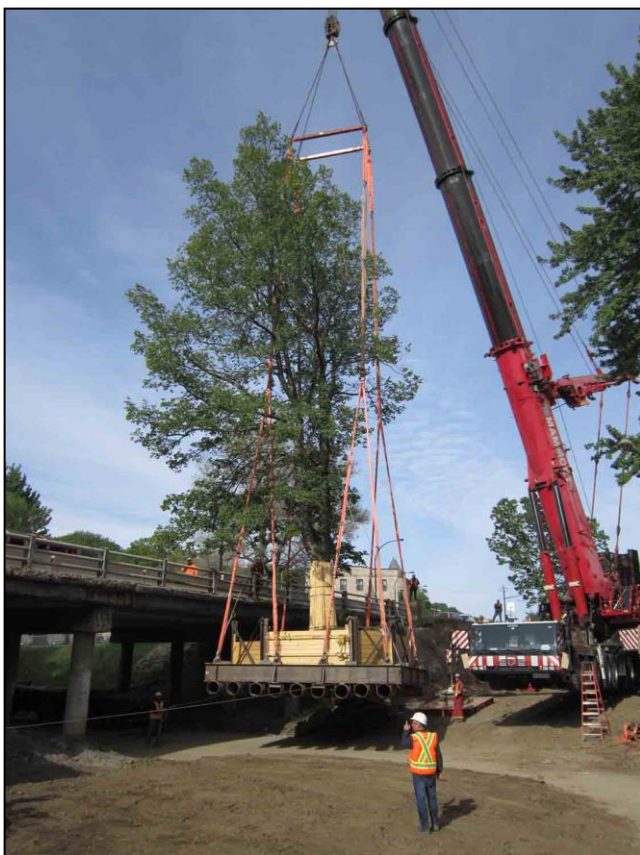
Photo 17 : Transplantation de micocoulier de 60 cm en motte de forme octogonale avec structure d'acier et de bois [source: NFU, projet ch. Remembrance/Côte-des-Neiges, Montréal]
