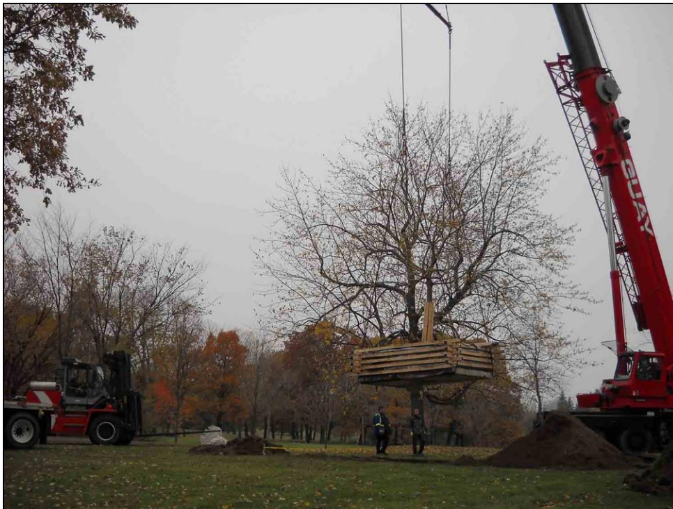
Photo 16 : Re-transplantation finale au site du parc Maisonneuve [source: NFU , projet de la Place d'Armes , Montréal]
