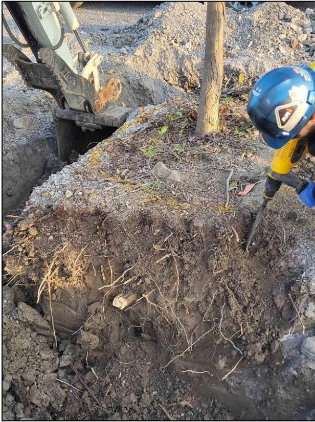
Photo 5 : Transplantation manuelle à l'aide d'une motte cordée – façonnage de la motte
