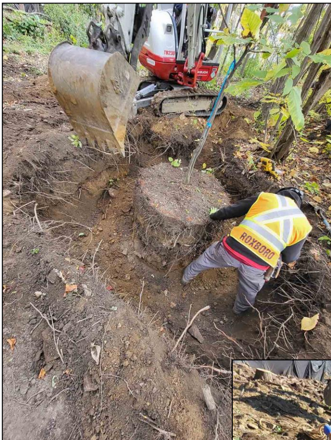
Photo 7 : Transplantation manuelle à l'aide d'une motte cordée – façonnage de la motte
