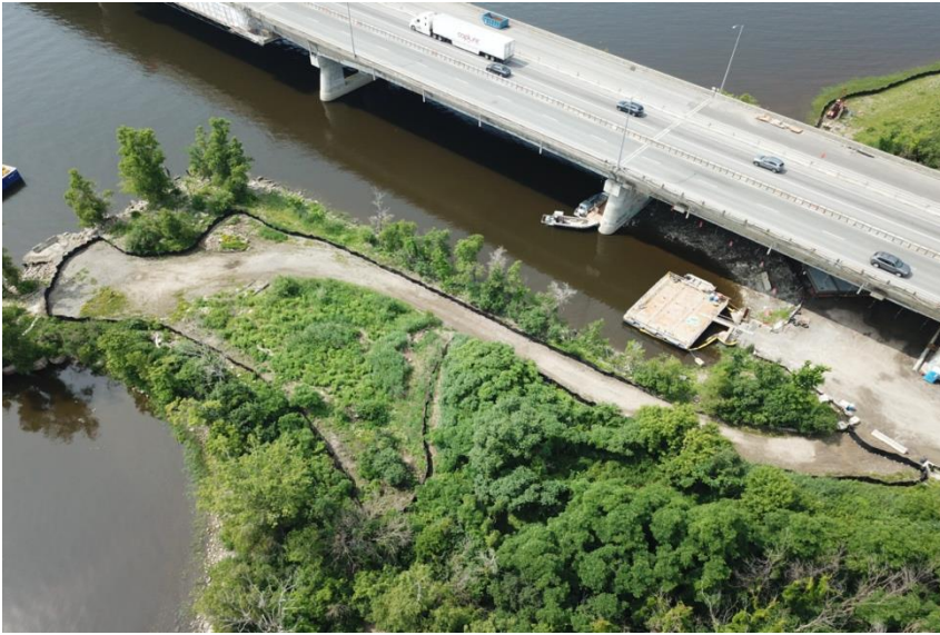
Photo 9- Barrière d'exclusion installée à la pointe sud-ouest de l'île Girwood
