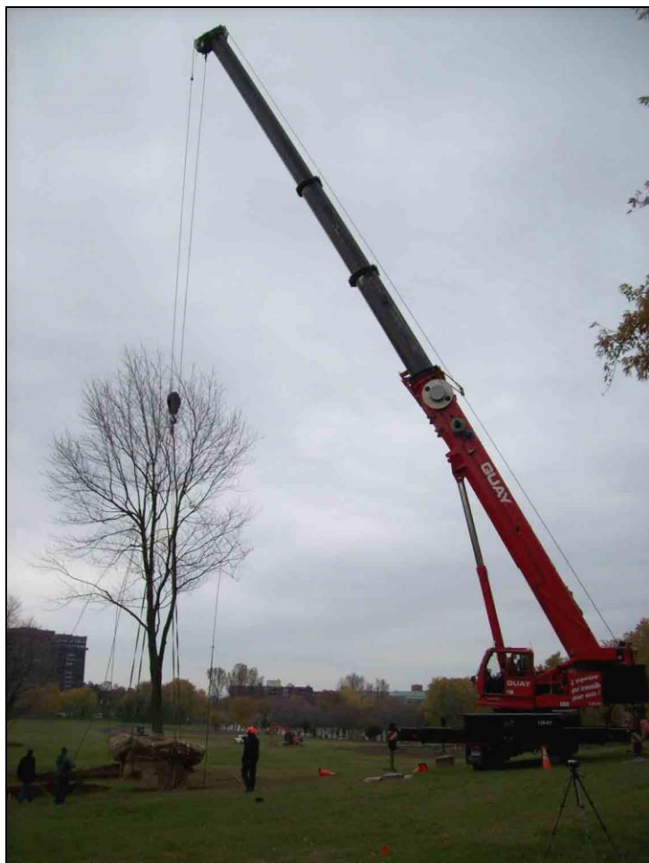
Photo 7 : Transplantation avec motte de 325 cm de diamètre façonnée manuellement (arbre de 40 cm de DHP), opération de descente de l'arbre vers la fosse de plantation [source: NFU, projet Voie cérémonielle du Cimetière Notre-Dame-des-Neiges, Montréal]
