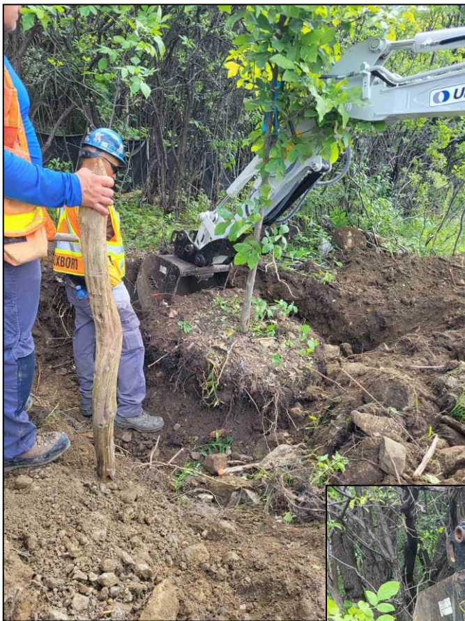
Photo 19 : Illustration du degré de présence de roches de tout calibre dans le sol
