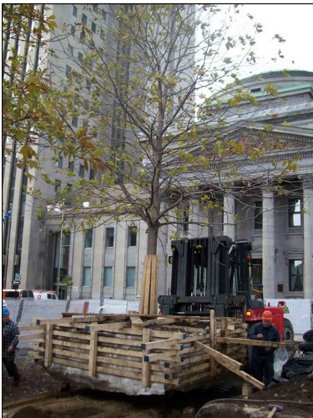
Photo 14 : Soulèvement d'arbre et transport avec élévateur à fourche [source: NFU , projet de la Place d'Armes , Montréal]
