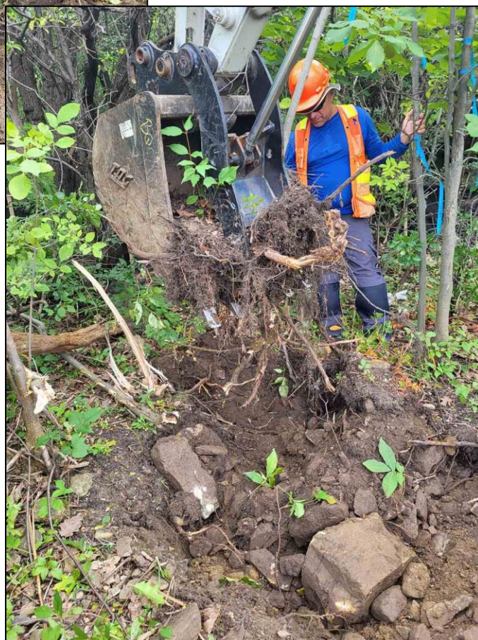
Photo 20 : Illustration du degré de présence de roches de tout calibre dans le sol
