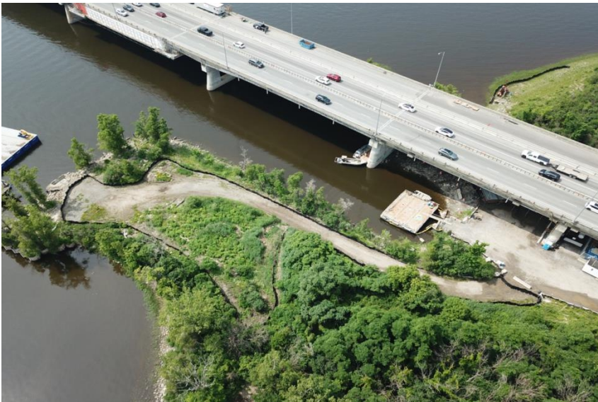
Photo 2- Barrières d'exclusion installées à la pointe sud-ouest de l'île Girwood
