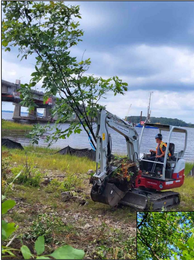
Photo 3 : Transplantation mécanique à l'aide d'une pelle excavatrice – transport de l'arbre
