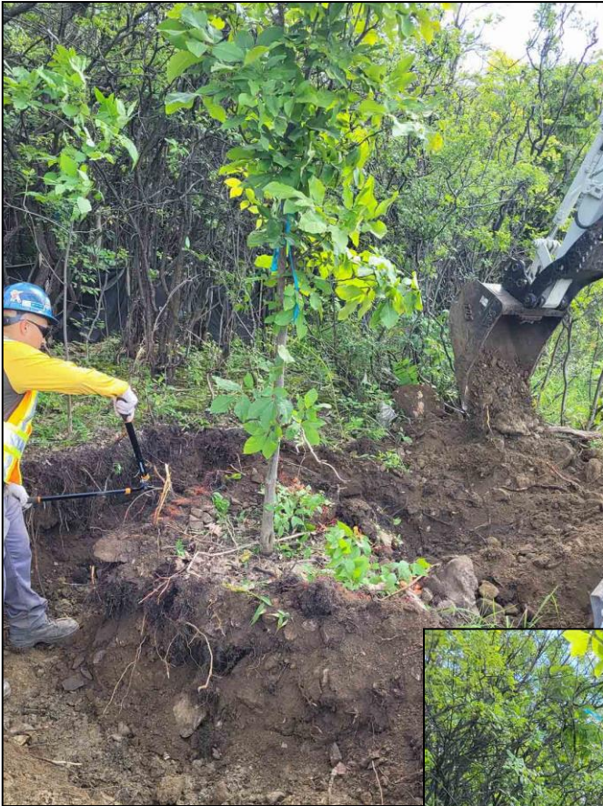
Photo 1 : Transplantation mécanique à l'aide d'une pelle excavatrice – découpage de la motte en carré
