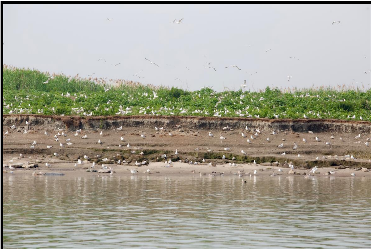
Figure 3. Érosion des berges et envahissement par la phragmite à l'île Deslauriers Photo prise par Pierre Molina en juin 2023
