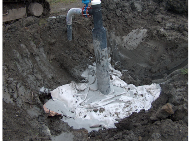
Pose de géocomposite au puits 353A
