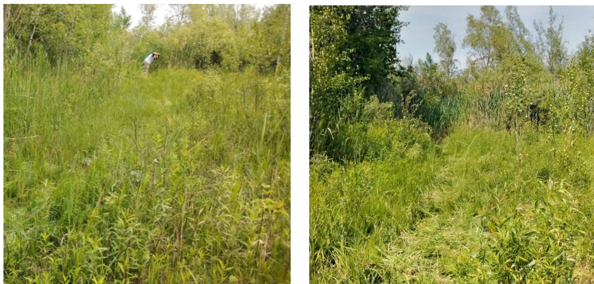
Figure 9. Travaux d'arrache du phragmite dans le corridor 1 (à gauche, pendant l'arrachage ; à droite, après l'arrachage)
