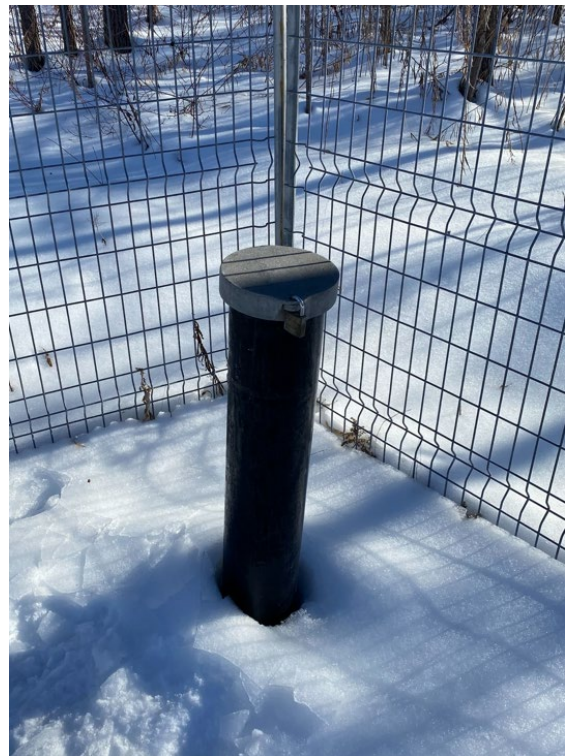
Photo 6 – Puits FE-400-039 le 5 février 2024
