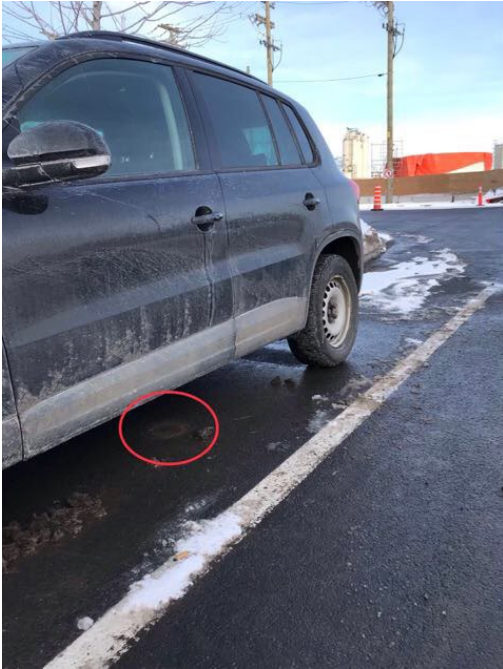
Photo 1 – Puits FG-400-035 (1/2) le 12 janvier 2023
