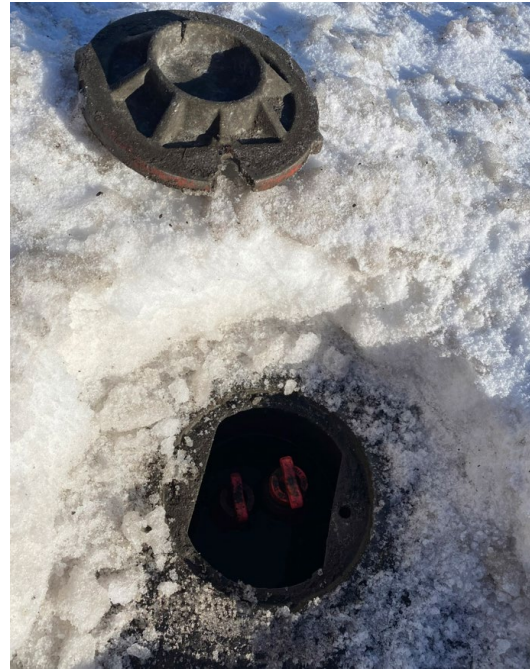
Photo 2 – Puits FG-400-035 (2/2) le 12 janvier 2023
